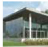
Site Desselgem INSULATION
